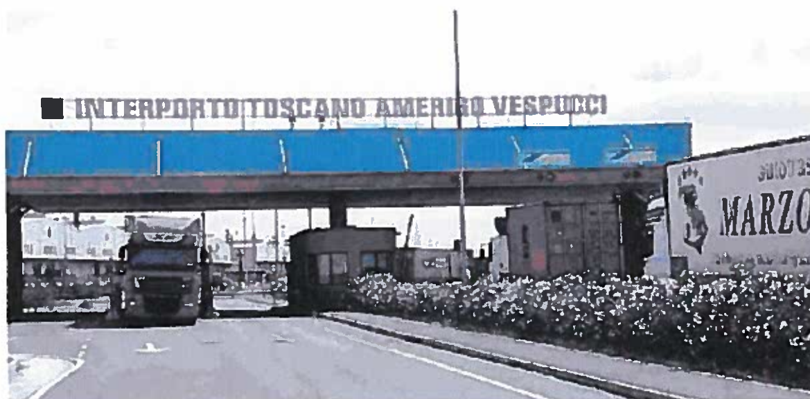
INFRASTRUTTURA L'interporto toscano Amerigo Vespucci rischia per il debito bancario
